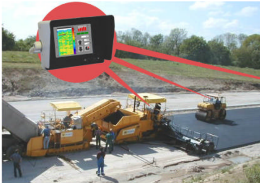
Abbildung 4. Flächendeckende Asphaltverdichtung im Einsatz auf der BAB A 20.
